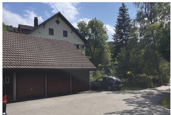
Garagegebäude von Strasse aus gesehen
