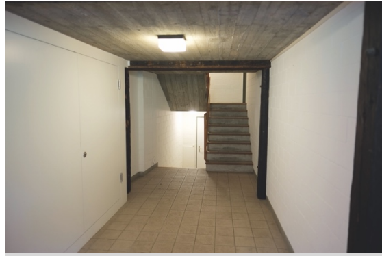
Treppenhaus Mitte, EG, Blick Richtung Norden
